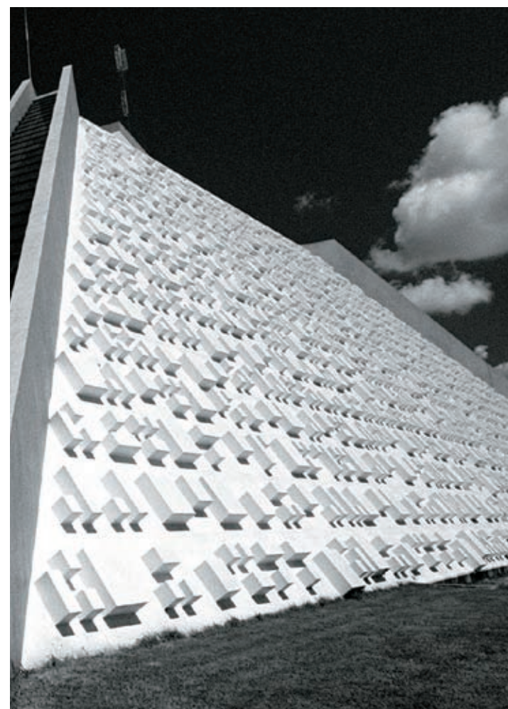
1 Detalhe da passarela do Palácio do Itamaraty 2 Fachada do Teatro Nacional 3 O mural do Memorial JK
