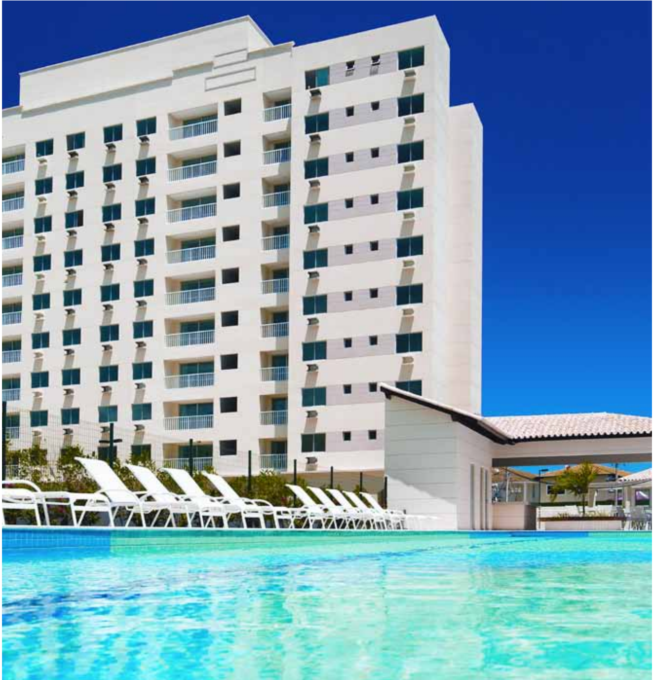
Empreendimento da Living Vita Residencial Clube Lauro de Freitas, entregue em Salvador (BA) Living's project Vita Residencial Clube Lauro de Freitas, delivered in the city of Salvador, Bahia
