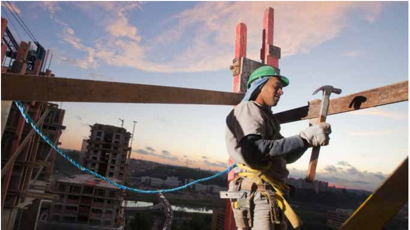
Operário na construção do empreendimento NovAmérica, em São Paulo | Worker in the construction of project NovAmérica, in São Paulo
