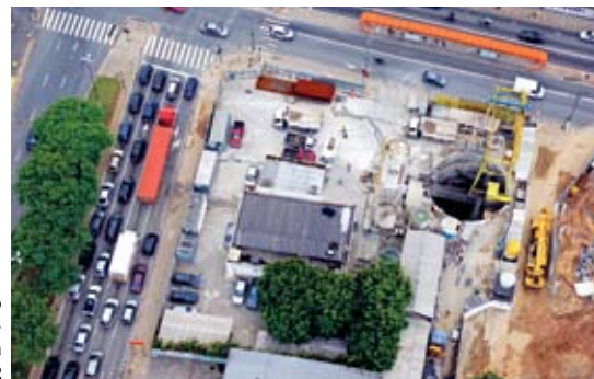
Obras na estação de metrô São Paulo-Morumbi, que fica pronta em 2012
